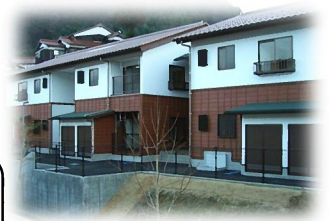
市営住宅 (一例)
